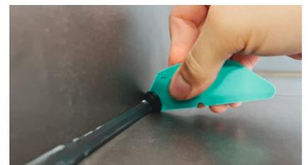
Lisser la masse d'étanchéité (ne pas appliquer le produit de lissage avec un vaporisateur)
