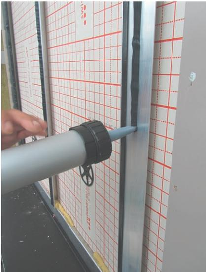
Montage préalable de PanelFix Tape (à gauche) à la verticale, à côté duquel on applique maintenant DOWSIL 896 PanelFix (à droite). Respecter une distance minimale de 20 mm.
